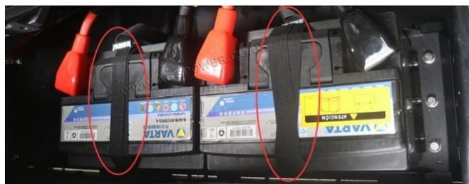
3) 底座固定方式：参考汽车上使用的底座固定方式。
